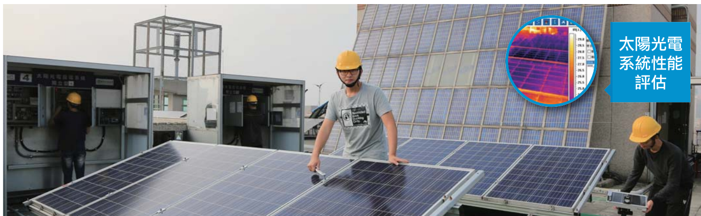
太陽光電設置技能檢定考場
