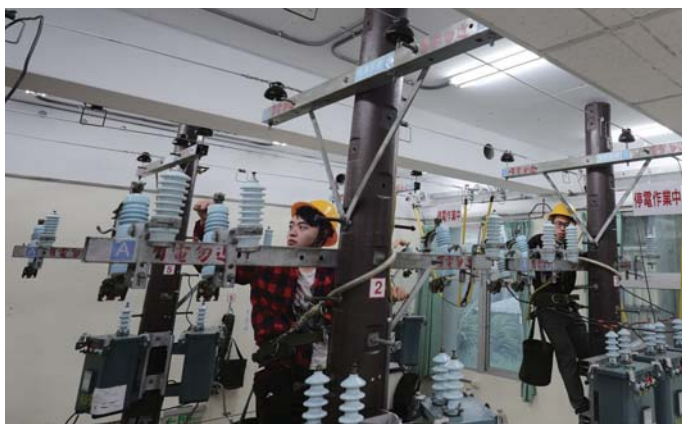
室內配線技能檢定考場
